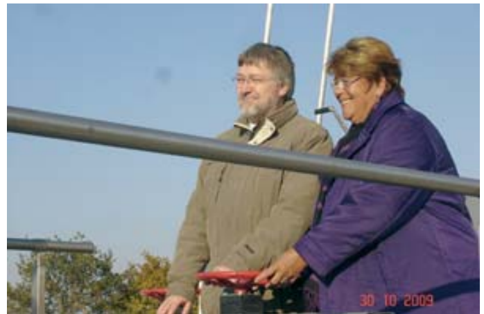
Bürgermeisterin Jutta Voß und Rainer Eberth, Geschäftsführer der Stadtwerke Lehrte, betätigen den Schieber für den Zufluss der neuen Kläranlage, und weihen so die Kläranlage in Ahlten gemeinsam ein.
